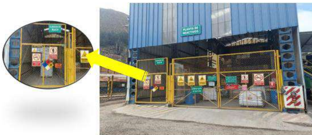
Figura N° 1: Zona de descarga de cianuro.
